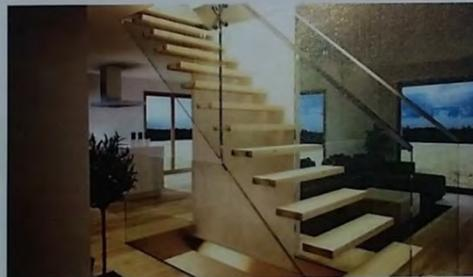
Os "vazios" dos degraus do segundo lance se configuram dessa forma, em balanço, e apresentam o guarda-corpo de vidro encaixado em sua lateral.
